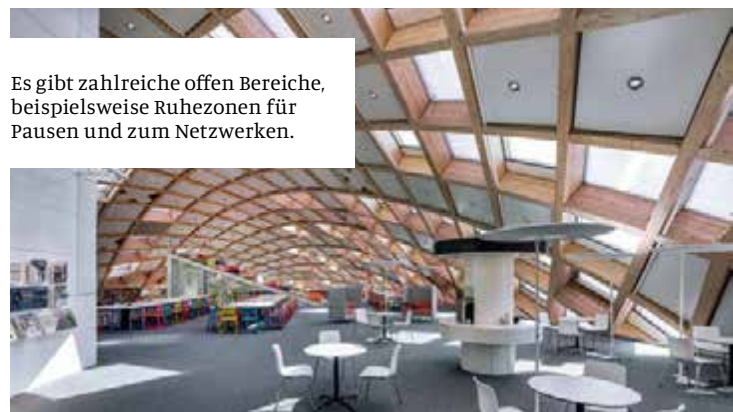
Jedes der vorgefertigten Teile ist ein Unikat, wurde von Blumer Lehman wie in ein Puzzle eingefügt.
